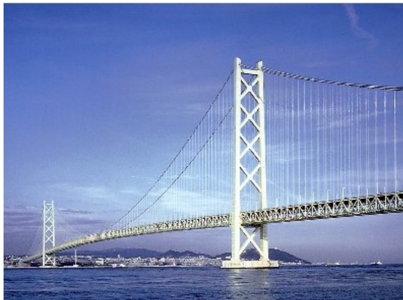
Figura 15: Ponte Akashi Kaikyo, Japão
